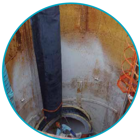
Vkládání složeného polštářového těsnícího vaku
